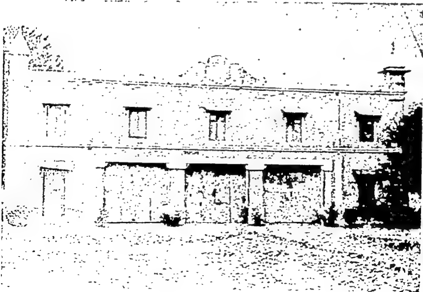
व्यायामशाला (वर्तमान) अध्यापक प्रशिक्षण भवन
